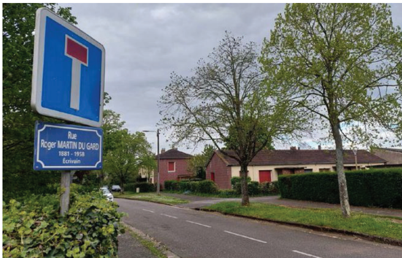
Trois logements vacants de la rue Roger Martin du Gard « et qui ne peuvent plus être loués » ont été retirés de la gestion par Logissia. Ils pourraient être détruits par la Ville... L'Orne hebdo
